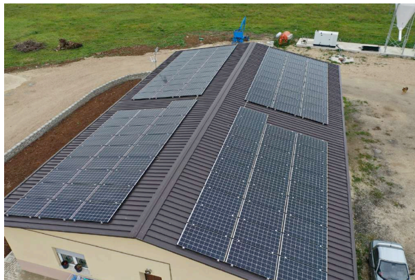
IMPIANTO FOTOVOLTAICO SU ABITAZIONE CUSTODE E MAGAZZINI
