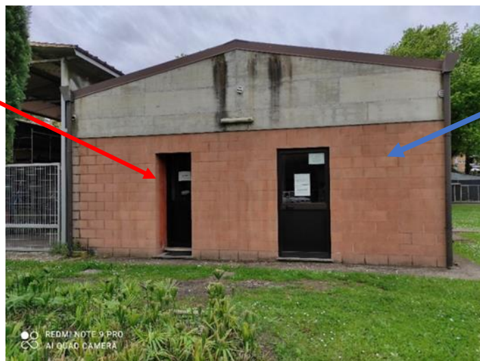
Foto n. 5 – locale pre-triage (freccia blu). La freccia rossa indica i servizi igienici annessi
